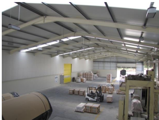
Fotografia nº 3 - Remodelação e Ampliação do Cais de Carga
