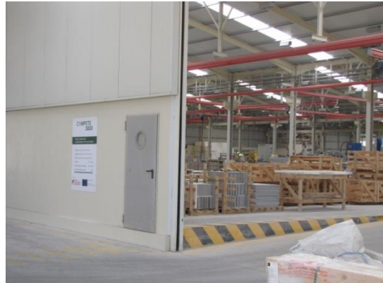
Fotografia nº 2 - Remodelação e Ampliação do Cais de Carga
